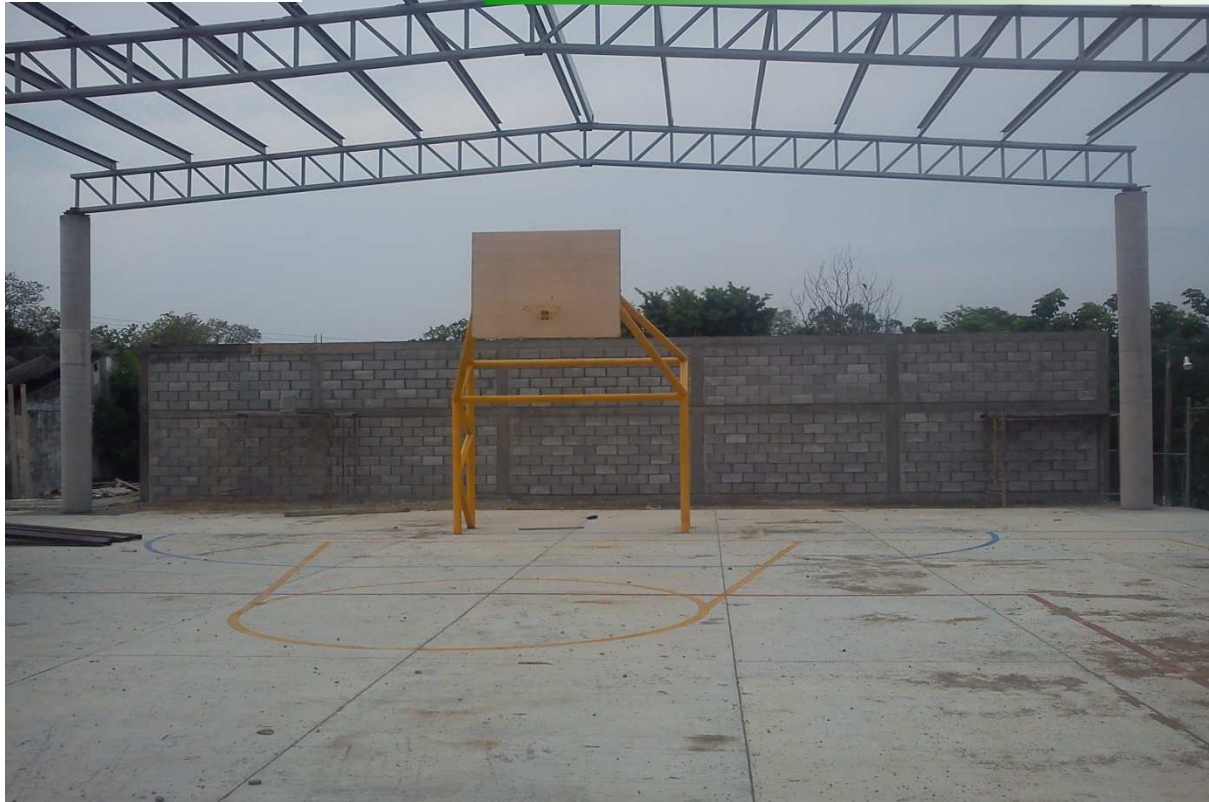
TECHO CUENCA COMUNITARIO LA CALERA CD. VALLES, S.L.P.
